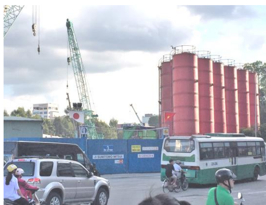
市街地の地下鉄工事
